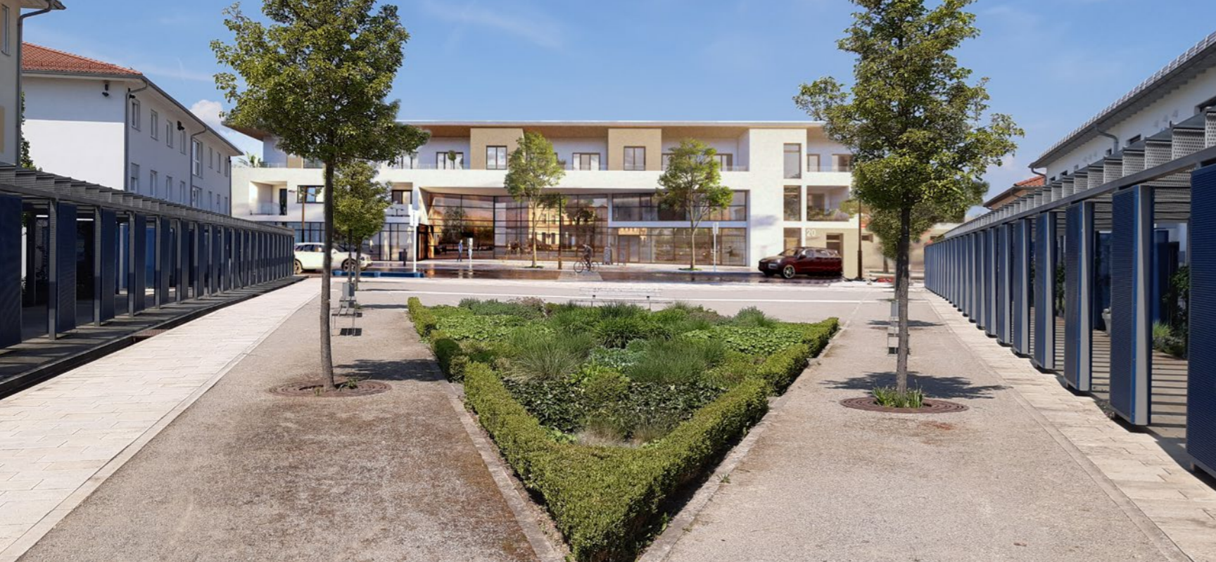
Das Architekturbüro Berz aus Augsburg hat im Herzen der Gemeinde ein ansprechendes und modernes Gebäude mit großen Glasfassaden entworfen.
