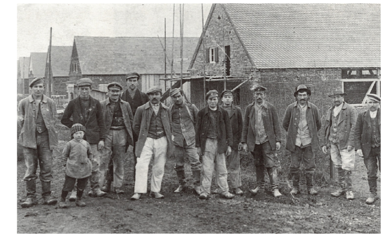
Bau der Meyfriedsiedlung mit Arbeitern im Vordergrund und Rohbauten im Hintergrund. (Foto: Heimatfreunde e. V.)
