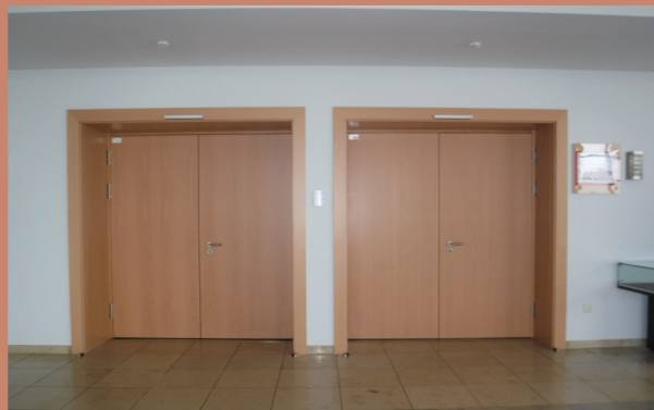
Die Brandschutztüren mussten ersetzt werden. Foto: Sandra Hanne
