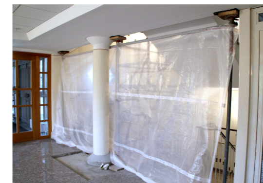
Der Aufzugbau geht voran. Hierfür wurde ein Gerüst und eine Staubschutzwand angebracht. Foto: Diana Sonntag
