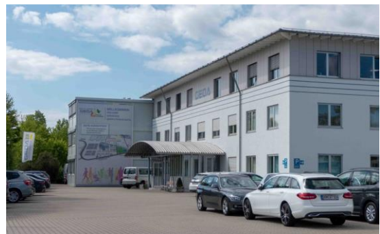
Abbildung 11: Mit dem Anbau von Bürocontainern versucht man, der Raumnot im Verwaltungsgebäude Herr zu werden
