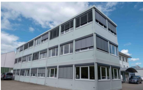
Abbildung 10: Mit dem Anbau von Bürocontainern versucht man, der Raumnot im Verwaltungsgebäude Herr zu werden
