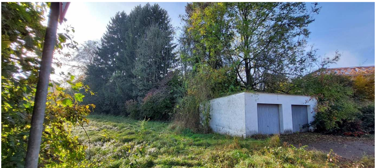
Abb. 5: Grundstück Meyfried 9 von der Ostseite her.
