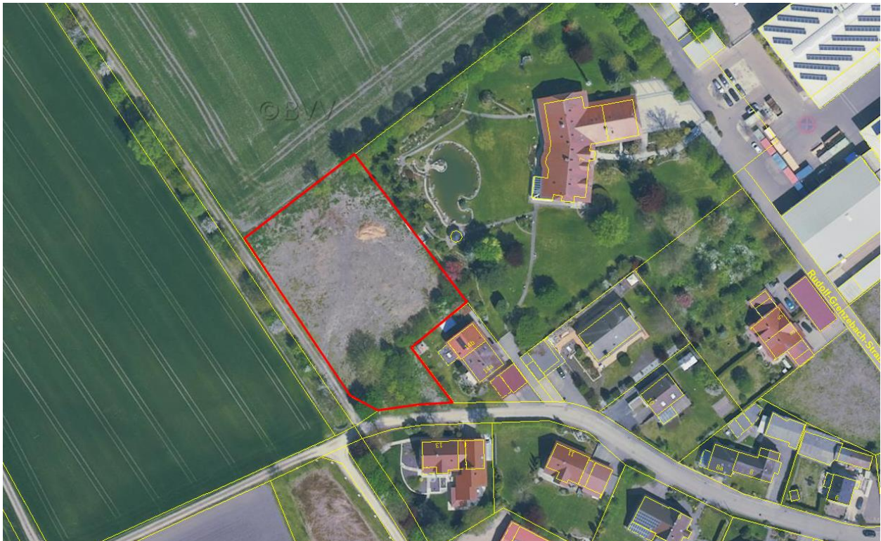
Abbildung 7: Luftbild vom Plangebiet (rot), o. M. (© 2021 Bayerische Vermessungsverwaltung)
