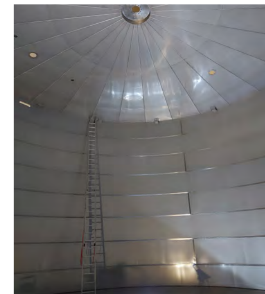
Der neun Meter hohe Speicher von innen.
