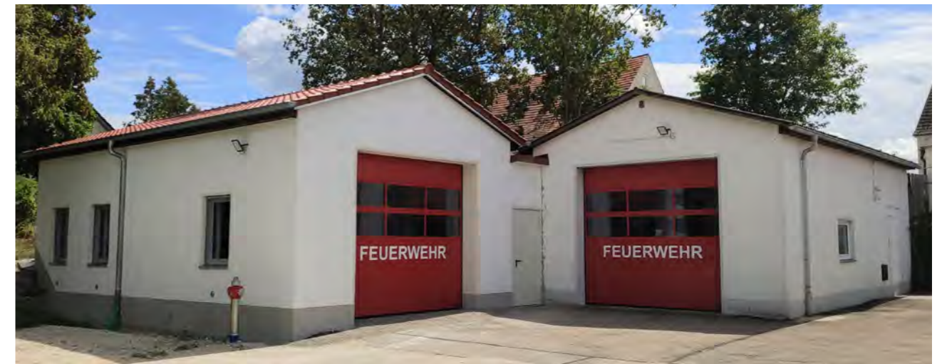
Die neu gebaute Fahrzeughalle (l.) kann sich sehen lassen. Foto: Diana Sonntag
