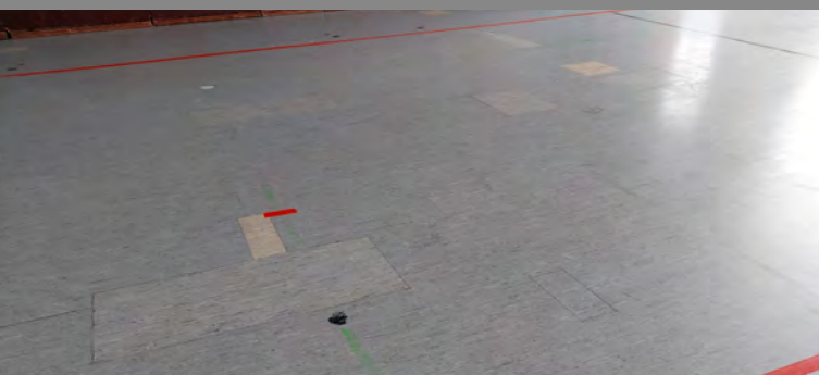
Insgesamt 45 dieser geflickten Stellen (Bild links) sind auf dem gesamten Hallenboden zu finden. Die Löcher (Bild rechts) weisen auf ein hohes Einbruchrisiko hin. Foto (l.): Martin Paninka, Foto (r.): Diana Sonntag
