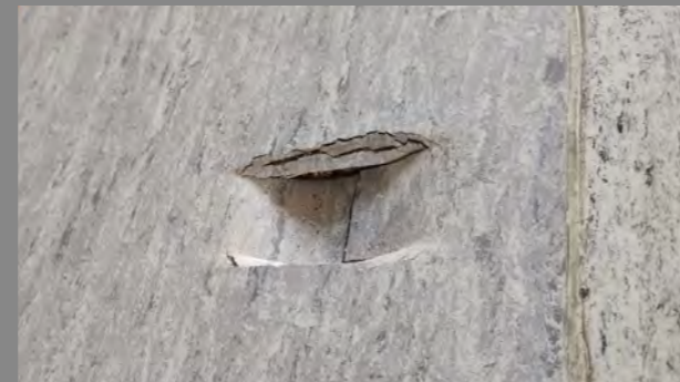
Insgesamt 45 dieser geflickten Stellen (Bild links) sind auf dem gesamten Hallenboden zu finden. Die Löcher (Bild rechts) weisen auf ein hohes Einbruchrisiko hin. Foto (l.): Martin Paninka, Foto (r.): Diana Sonntag
