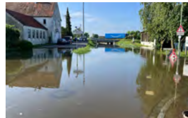
Die überflutete Unterführung in Hamlar. Foto: Christian Lix
