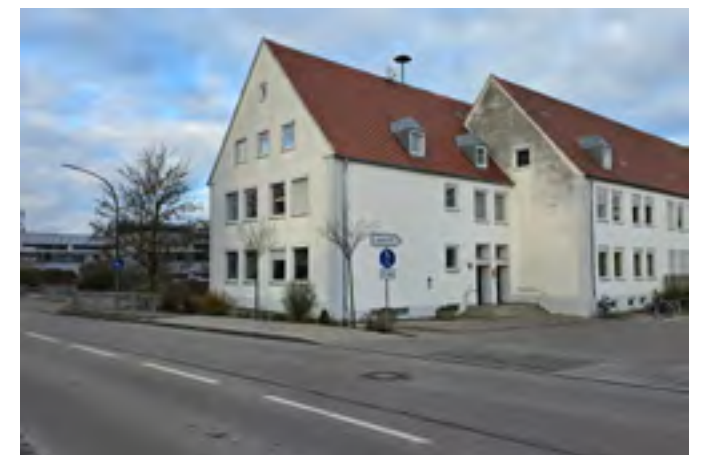
Aktuelle Bilder zum Projekt „Neubau Schule und Hallenbad“. Fotos: Martin Paninka
